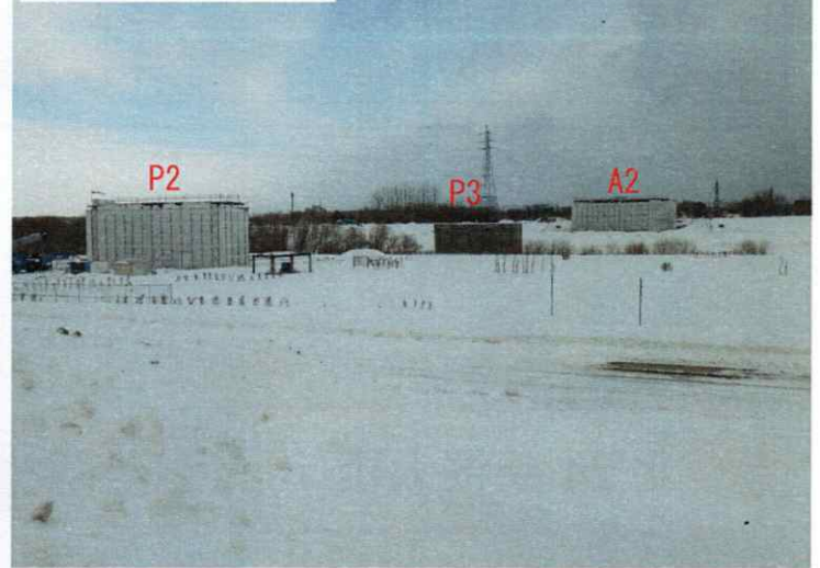
河川内施工状況
